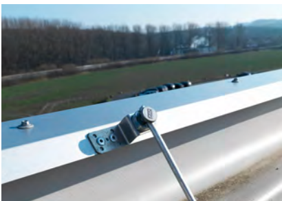
Anschluss der Attika an das Blitzschutzsystem
